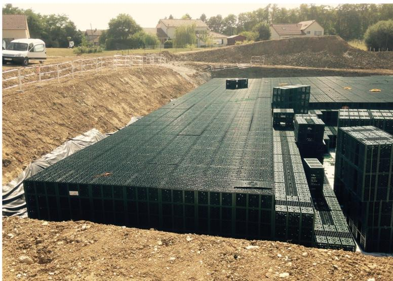
Une 1ère phase de travaux s'est déroulée de fin juin à mi-septembre, profitant d'une météo particulièrement clémente pour creuser l'énorme trou nécessaire à la mise en place du bassin de rétention enterré pour récupérer les eaux pluviales du terrain de la maison de retraite et de toute la longueur de la voie de Beaulieu, désormais drainée.
