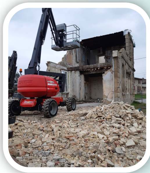
Démolition de la mairie de Senard
