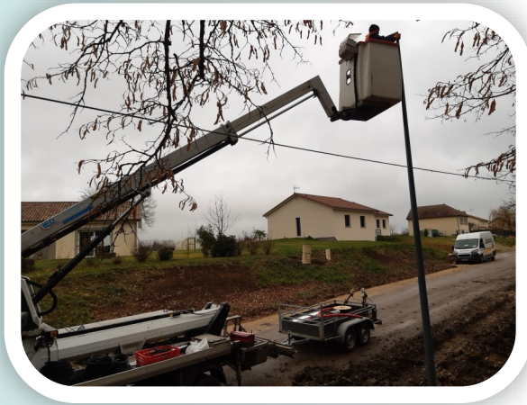
Pose de lampadaires éclairage Led
